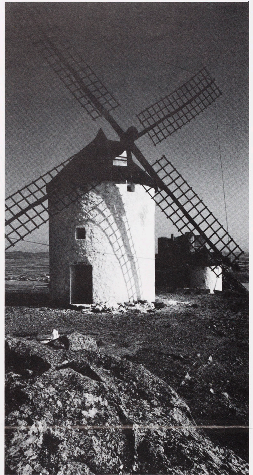
Consuegra: Erhöhung über La Mancha Burg-Ruine aus vormaurischer Zeit
